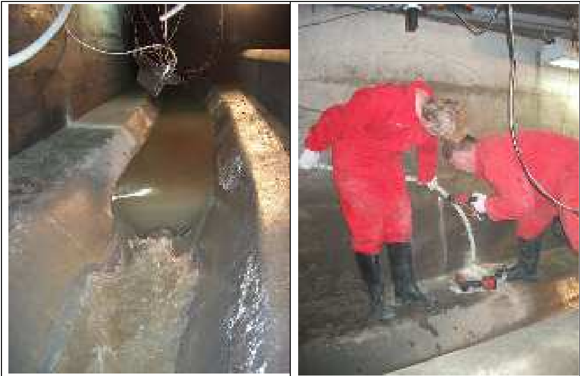
Abbildung 60: Verlegung des Bypass-Ansaugpunktes kanalaufwärts, vor das Staublech
