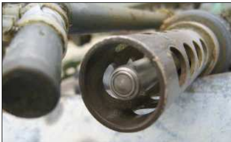
Abbildung 69: Detailansicht der Sauerstoffelektrode mit dem Druckluft-Spülungsrohr (links)
