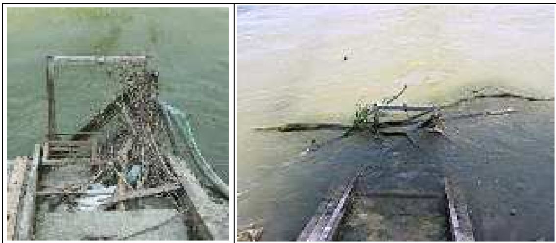
Abbildung 72: Verklausungen am Sondenkorb durch Treibholz und Müll.
