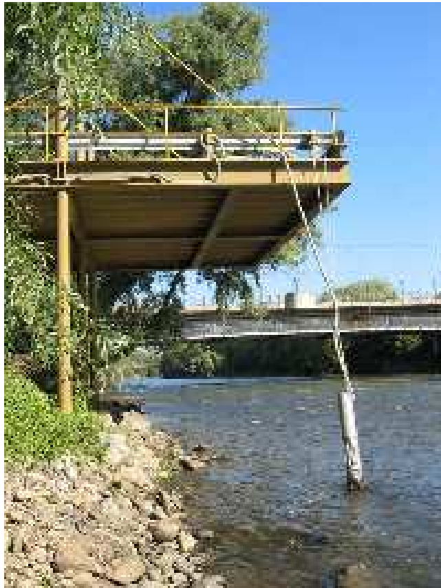
Abbildung 28: Immissionsseitiges Sondensystem in der Mauer zur Erfassung des Einflusses von Mischwassereinleitungen oberhalb der Messstation, Schneeabwurfstelle des Wirtschaftshofes der Stadt Graz
