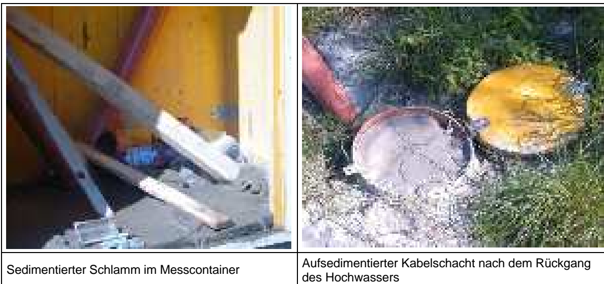
Abbildung 71: Folgen des Hochwassers vom August 2002 für die Messstation.
